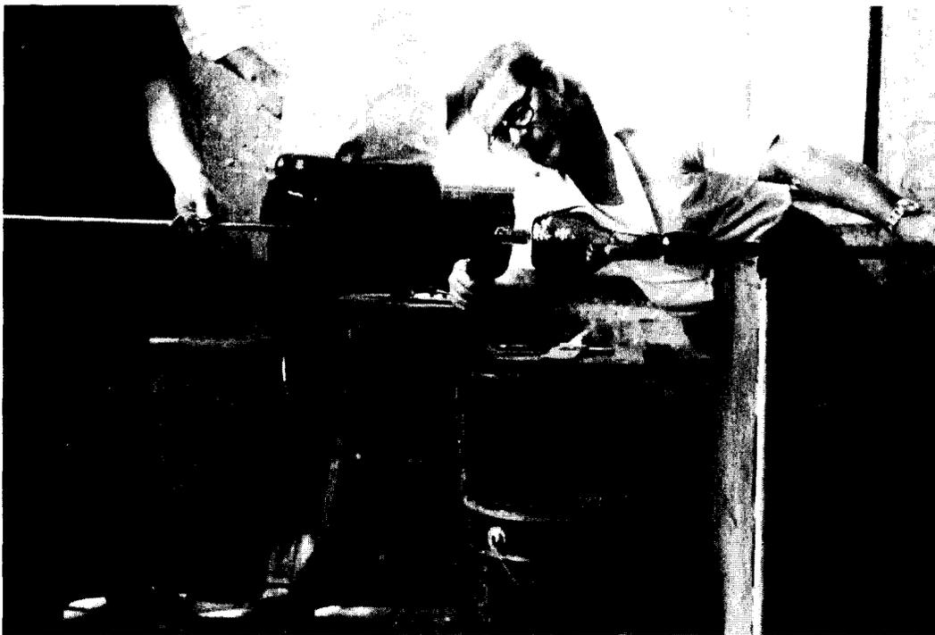
**Figure 70.** Pour façonner l'extrémité de la bouteille, on la fixe au pontil par le cul. Le verre au bout du pontil laisse une marque reconnaissable appelée marque de pontil (Chalet Glassworks, Cornwall, Ontario). (Photo: O. Jones; RA-3599M.)
